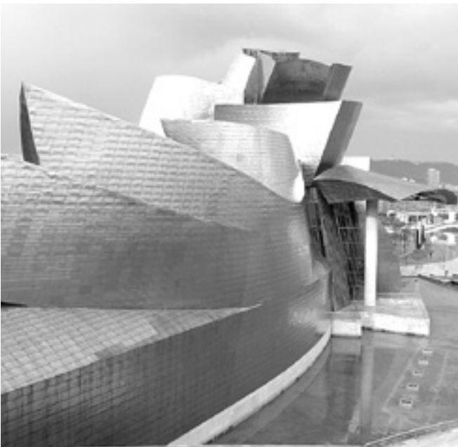
Muzej Guggenheim u Bilbao – za razliku od savršeno složene epiderme u čeličnim trokutima u Kamenskoj, u Bilbao je epiderma izvedena u pravokutnicima od titana koji su morali biti pojedinačno savijani
